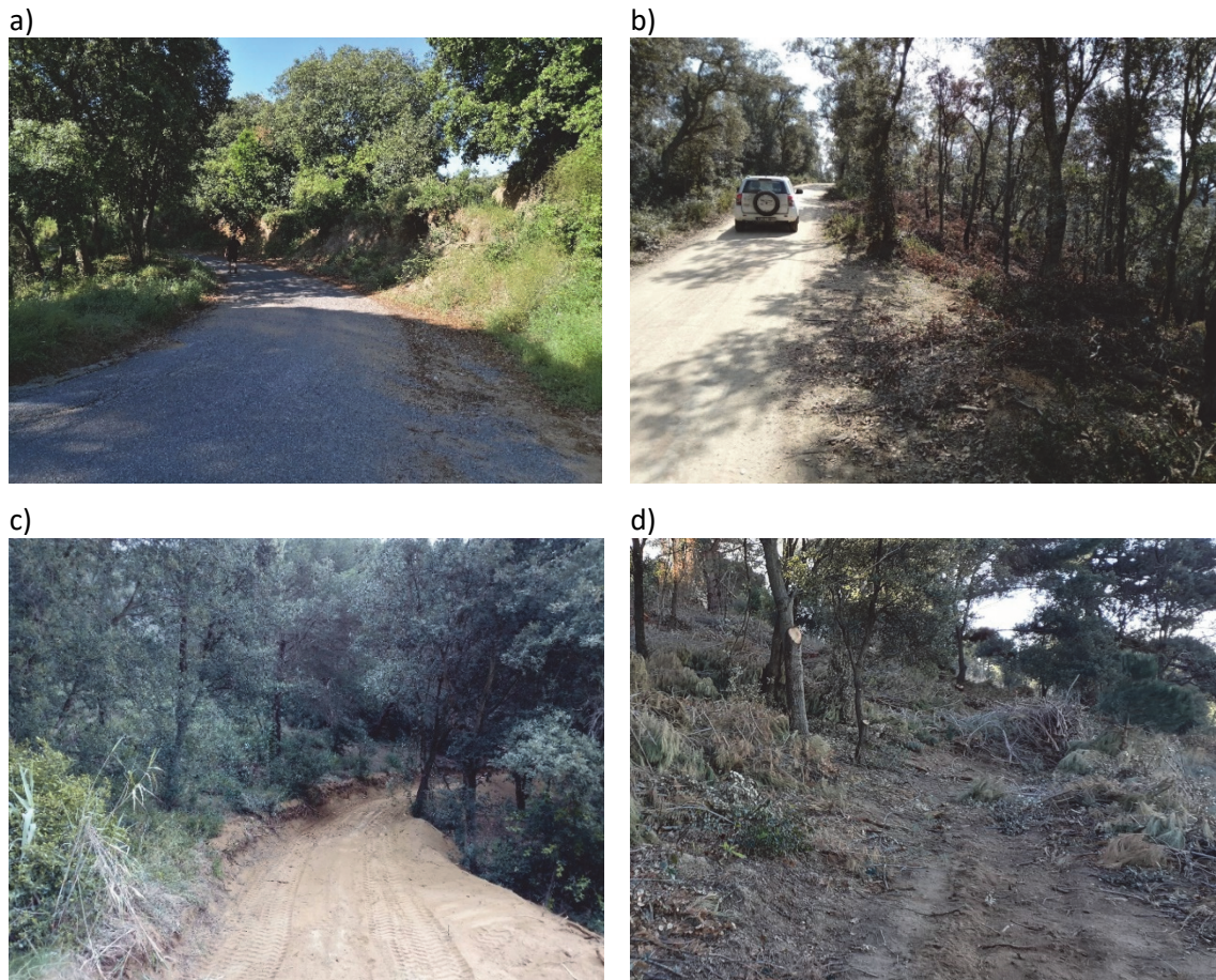
Figura 20. Tipo de vías forestales: a) vía principal revestida, b) vía principal de menos de 5 m de ancho, c) vía de desembosque, d) arrastradero.
