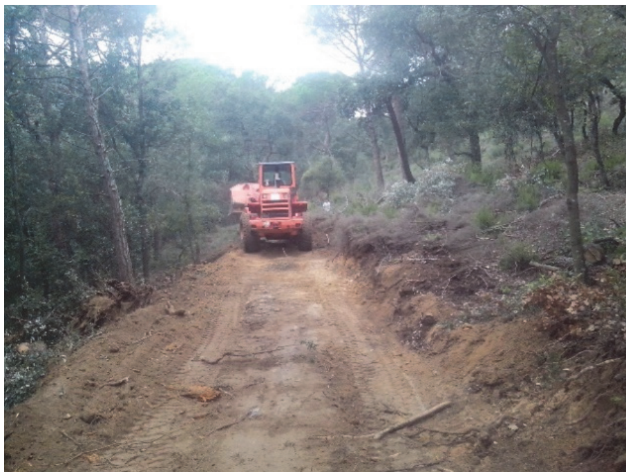
Figura 21. Máquina abriendo un camino de nueva construcción.
