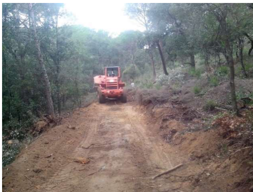
Figura 21. Máquina abriendo un camino de nueva construcción.
