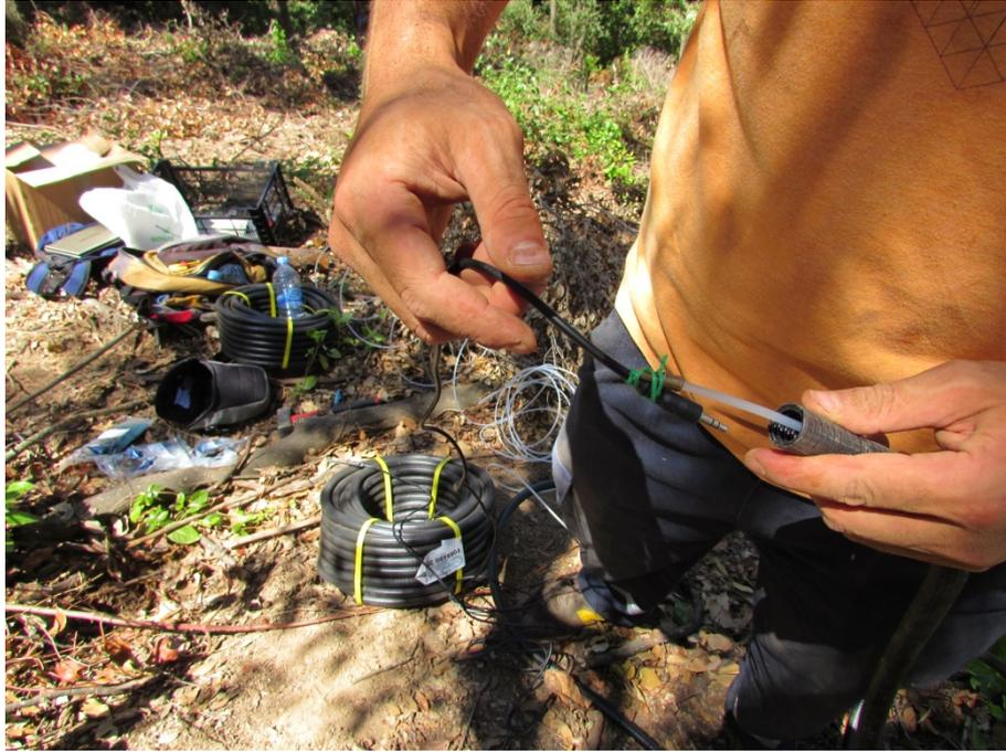
Preparación del cableado de las sondas de humedad del suelo
